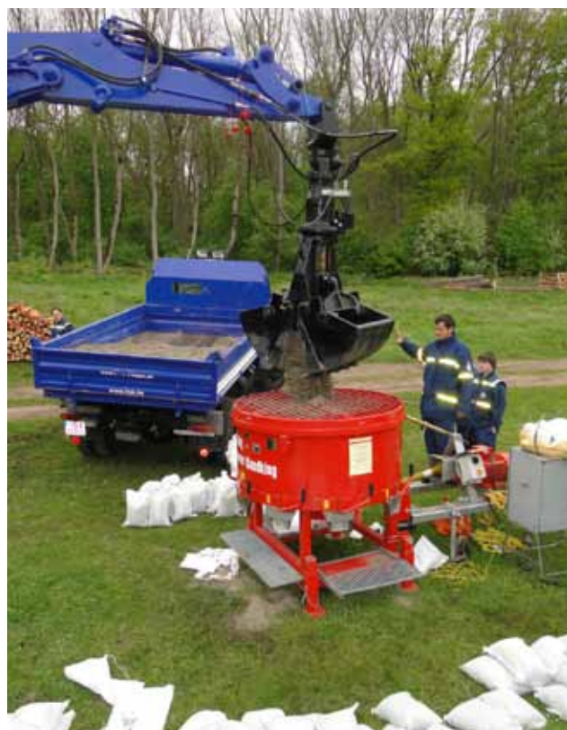
Deichverteidigung auf dem Ausbildungsplan des THW Dillingen, in Lauingen am Damm der Donau-Staustufe. Hier haben die Helfer die Sandsackfüllanlage des Landkreises in Betrieb genommen. Durch die leistungsfähigen Maschinen des Ortsverbandes ist es möglich, über eine lange Zeitdauer die Füllmaschine an der maximalen Kapazität zu betreiben und auch den Nachschub an Sand sicherzustellen.
